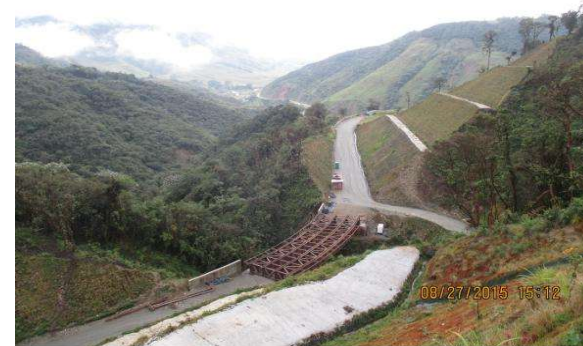
VISTA GENERAL CONSTRUCCION PUENTE 4 - K4+986
