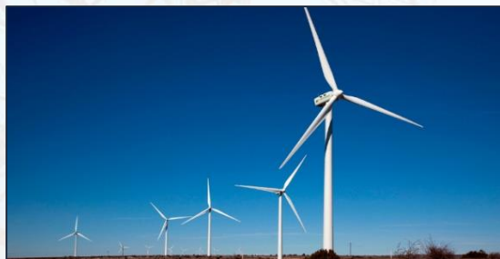
Parque eólico 7.5 MW incluido en concesión actual
