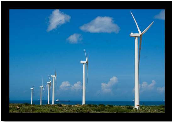
Energización con fuentes renovables en Zonas No Interconectadas
